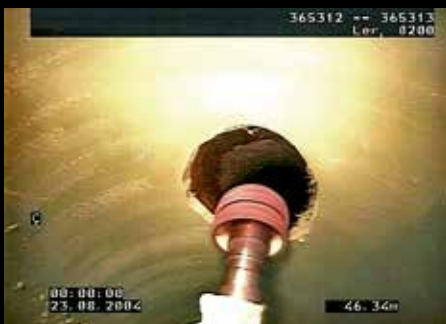
Robot using B&J CW 50 x 25 for reopening of lateral connections / Robot con B&J CW 50 x 25 para abrir un empalme lateral
